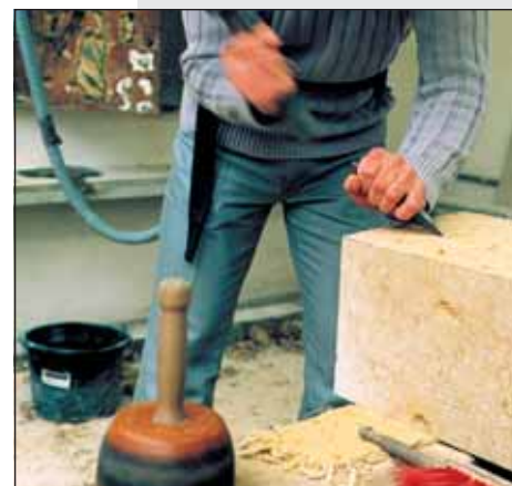
Ein Stein für die Kuppel der Dresdner Frauenkirche soll bearbeitet werden. Nach dem Studieren der Zeichnung wird die Reihenfolge der Arbeitsschritte festgelegt.
