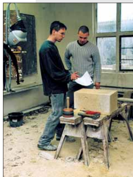
Ein Stein für die Kuppel der Dresdner Frauenkirche soll bearbeitet werden. Nach dem Studieren der Zeichnung wird die Reihenfolge der Arbeitsschritte festgelegt.
